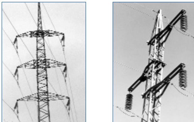
Рис.1. Типовая доработка линий на напряжение 150 и 70 кВ
