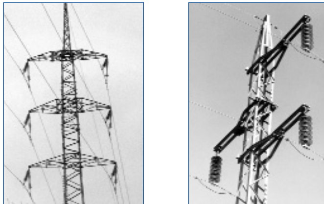
Рис.1. Типовая доработка линий на напряжение 150 и 70 кВ
